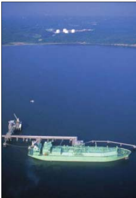
Dominion Cove Point LNG LP's Cove Point LNG installation. Photo from Dominion.
